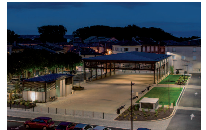
Bétons sablés et désactivés clairs mats photo chantier fini
